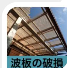
強風による飛来物激突の影響で波板が破損してしまっている。
